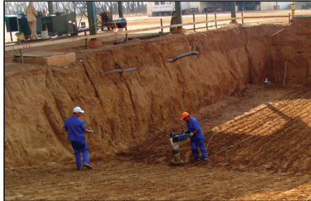
Início das obras segunda “ETE”
