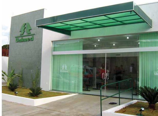
Fachada do novo Pronto Atendimento
