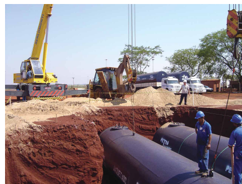
Instalação dos tanques de combustível do novo posto de abastecimento.
