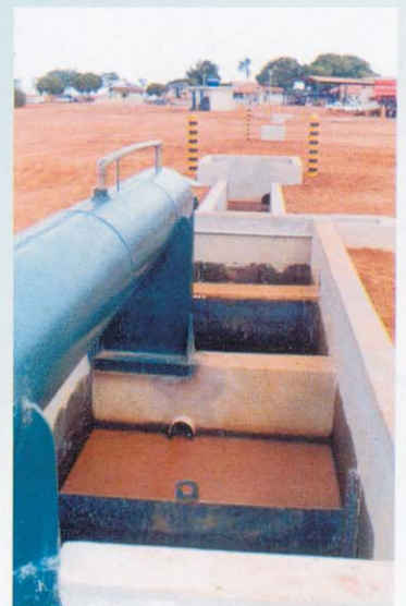
Vala de recebimento e limpeza de água
